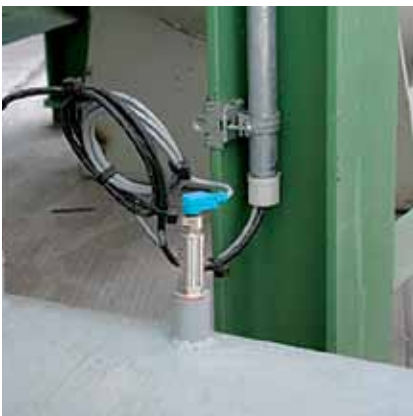
Monitorización de un sistema de tuberías mediante sondas de temperatura y termostatos compactos
