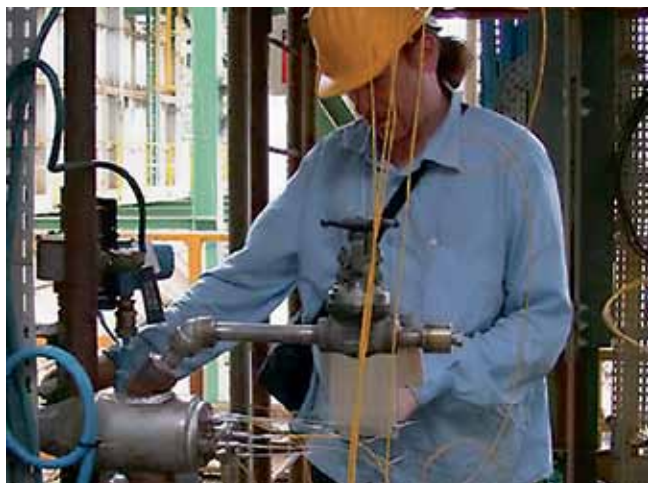
Mantenimiento de una cámara de seguridad y diagnóstico instalada
