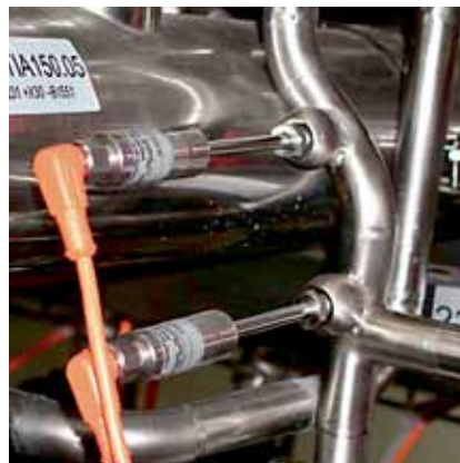
Monitorización de un sistema de tuberías mediante sondas de temperatura y termostatos compactos
