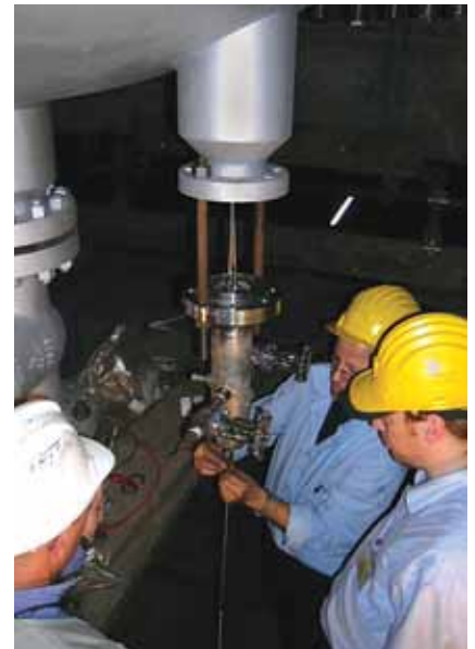
Instalación de un termopar multipunto
