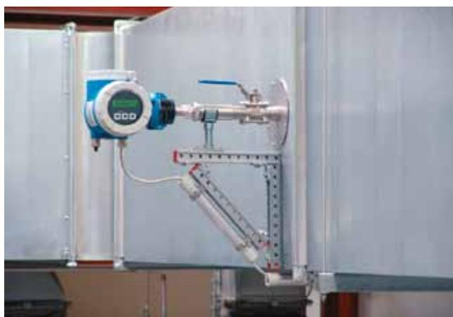
El principio de medida por dispersión térmica se utiliza ampliamente en la industria por su eficacia en muchas aplicaciones con caudales de gas, por ejemplo:
